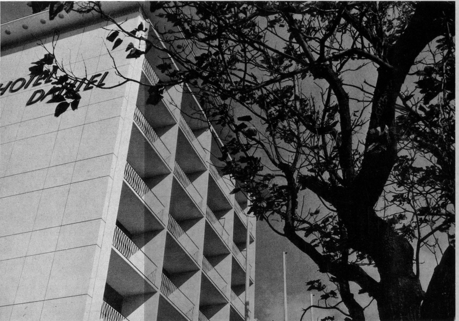
Bauen für den Fremdenverkehr
